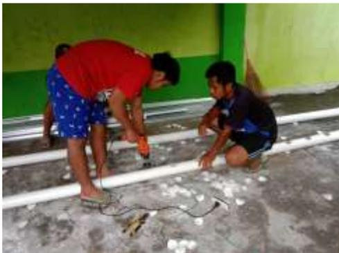
Gambar 3. Proses pelubangan pipa
